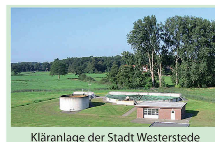
Kläranlage der Stadt Westerstede
