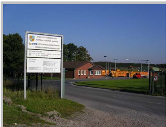
Die Zufahrt zum Deponiegelände
