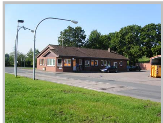
Die Waage und das Betriebsgebäude
